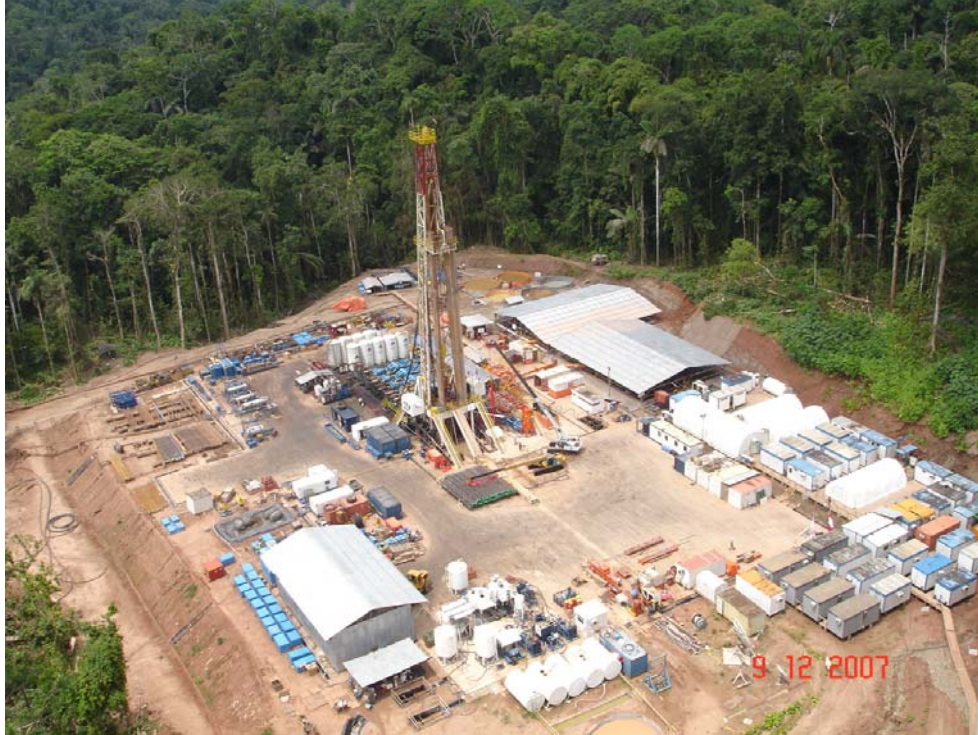
Vista panorámica del pozo exploratorio Kinteroni X1
